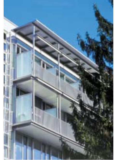
Geschosshohe Fassadenelemente mit emailliertem Glas und elektrisch betriebene Lamellenstoren charakterisieren den Neubau.
