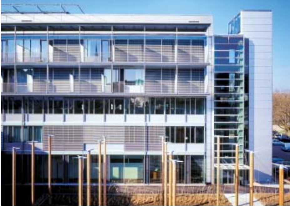
Geschosshohe Fassadenelemente mit emailliertem Glas und elektrisch betriebene Lamellenstoren charakterisieren den Neubau.
