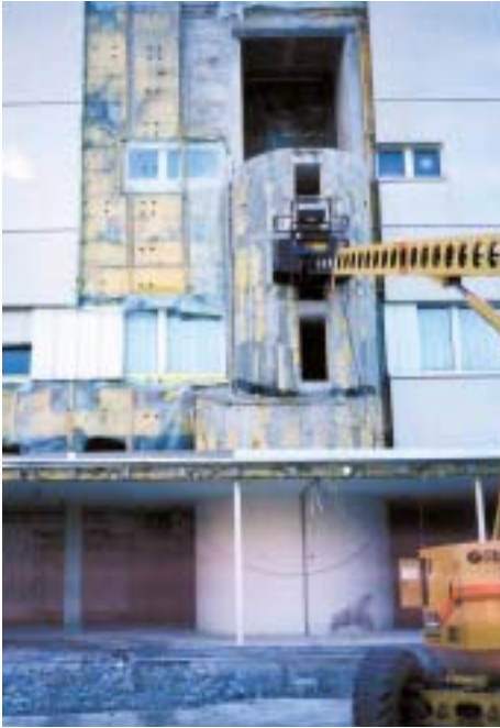
Abbrucharbeiten für die Andockstelle des Erweiterungsbaus und schwebende Aussentreppe.
